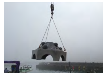
人工魚礁の沈設の様子
