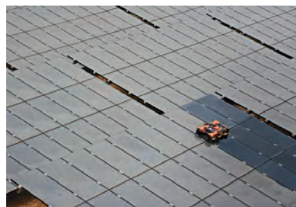
ロボットによる清掃の様子
